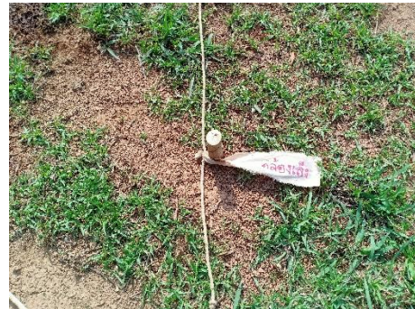
๑.๗ พลเล็ง นำหมุดไม้ จำนวน ๑ หมุด ปักตรงจุดหมายระยะกึ่งโค้งเล็ง
