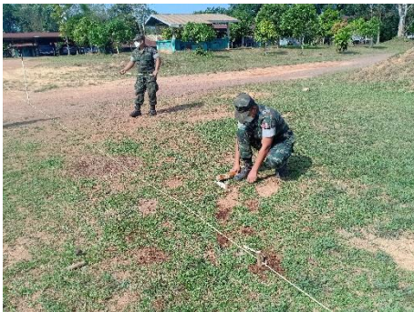
๑.๗ พลเล็ง นำหมุดไม้ จำนวน ๑ หมุด ปักตรงจุดหมายระยะกึ่งโค้งเล็ง
